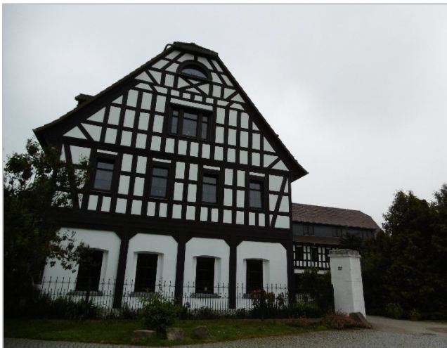
saniertes Fachwerkgehöft, Großstörnitz/Schmölln
