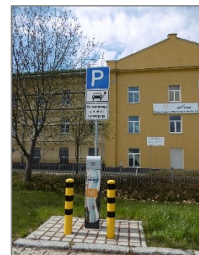
Ladestation am Bahnhof Schmölln
